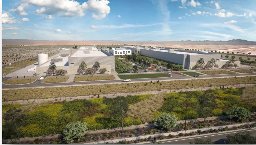
Meta Datacenter – Mesa, AZ
